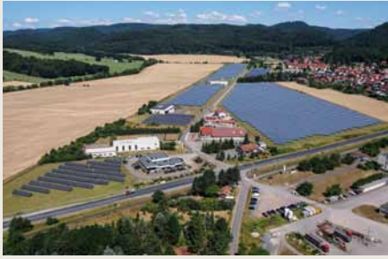
Der thüringische Solarpark Ilfeld ist seit Dezember 2011 in Betrieb.
